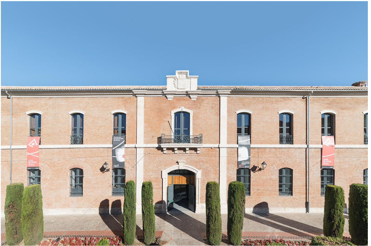
External façade at Lope de Vega, Alcalá de Henares
